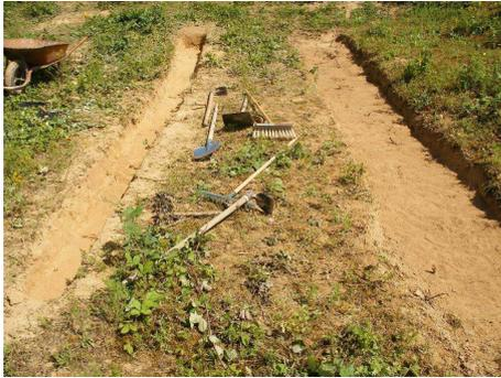
FIG. 5.2 – Préparation du sol. On arrache les herbes et on nettoie le sol.
