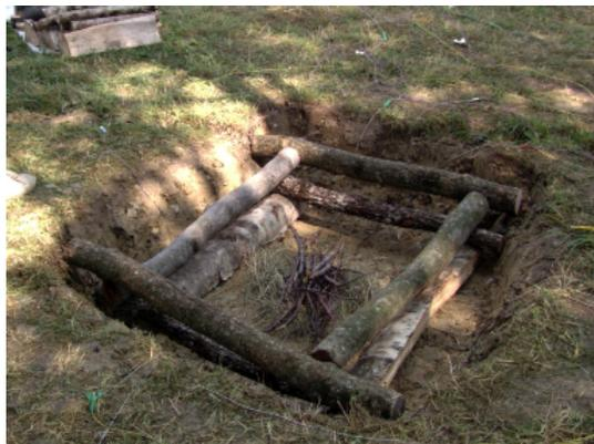
FIG. 5.26 – Disposition du bois à l'intérieur du foyer.
